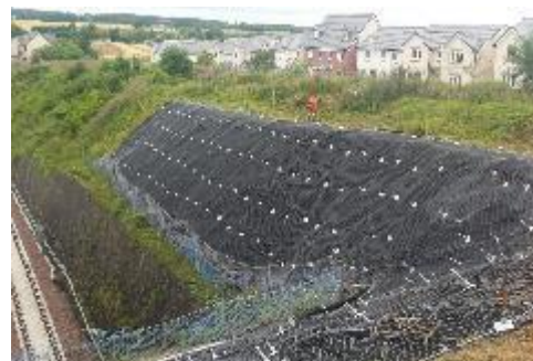
Применение буро-инъекционных анкеров обеспечивает безопасность окружающих зданий, подземных трубопроводов и дорог.
