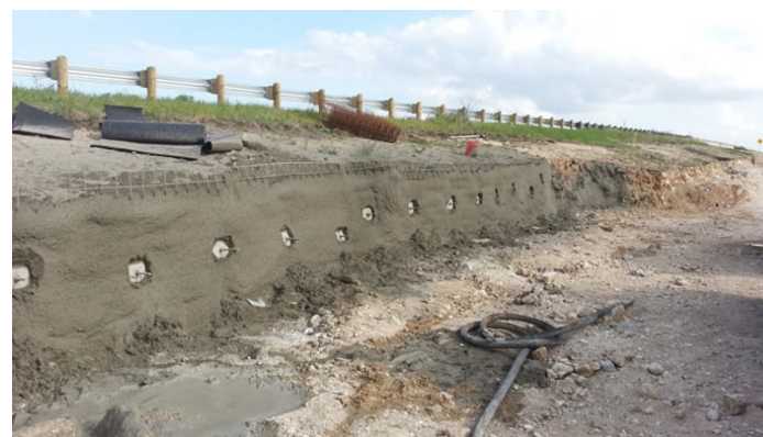
Применение буро-инъекционных анкеров обеспечивает безопасность окружающих зданий, подземных трубопроводов и дорог.
